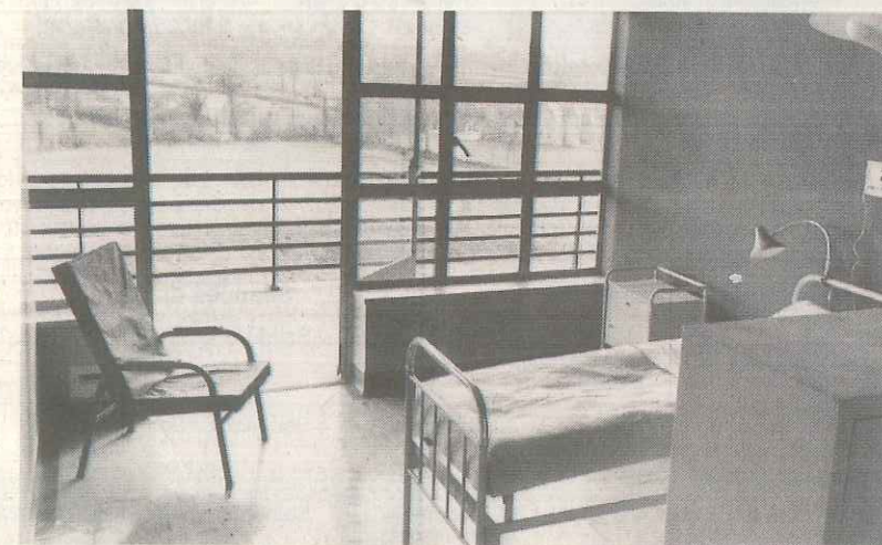
Une chambre de l'hôpital fraîchement construit.
